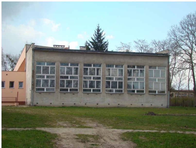
Zdjęcie 16 Sala Gimnastyczna ZKiW w Smętowie Gr. przed remontem ( zdjęcie z archiwum Urzędu Gminy)
