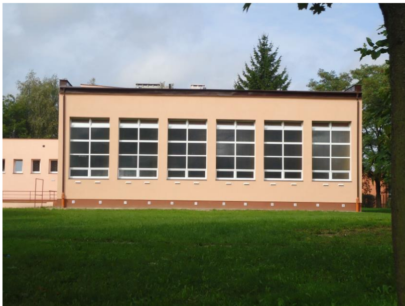
Zdjęcie 17 Sala Gimnastyczna ZKiW w Smętowie Gr. po remoncie ( zdjęcie z archiwum Urzędu Gminy)
