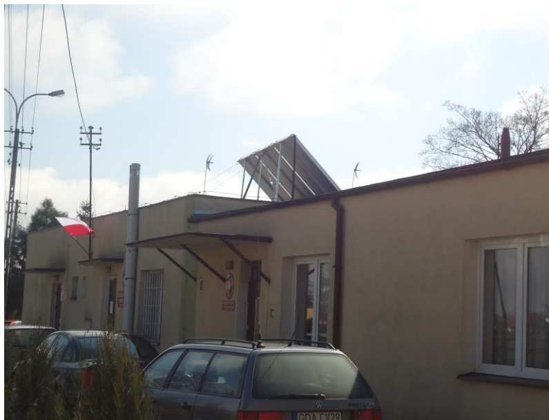
Zdjęcie 19 Budynek Urzędu Gminy w Smętowie Gr. po zamontowaniu płyt solarnych( zdjęcie z archiwum Urzędu Gminy)
