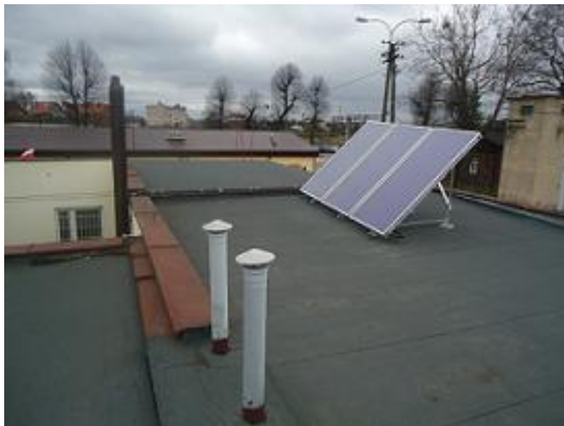
Zdjęcie 18 Budynek Urzędu Gminy w Smętowie Gr. po zamontowaniu płyt solarnych( zdjęcie z archiwum Urzędu Gminy)
