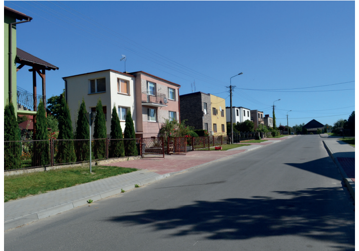
Nowo wyremontowany chodnik przy ul. Spacerowej.
