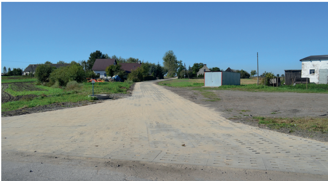
Kolejna ulica, tym razem ul. Wybudowania została poddana modernizacji.
